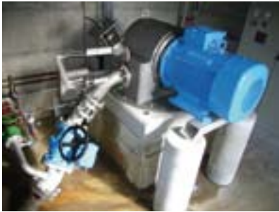
Bild 6: Typische Beispiele von Pelton-Turbinen: links horizontal-achsige (Quelle: J-M. Chapallaz, Baulmes) und rechts vertikal-achsige (Quelle: Zobo, Brienz)
