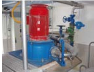
Bild 6: Typische Beispiele von Pelton-Turbinen: links horizontal-achsige (Quelle: J-M. Chapallaz, Baulmes) und rechts vertikal-achsige (Quelle: Zobo, Brienz)
